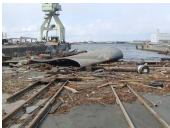
被災直後の様子（石巻地区）
