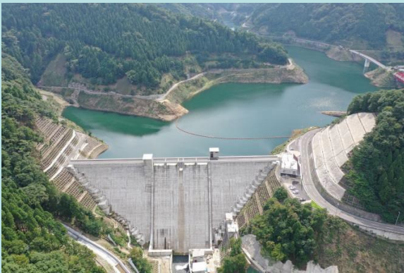
令和元年度に完成した河内川ダム
