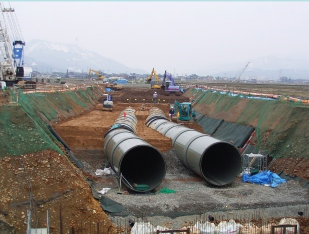
既設開水路を取壊しパイプライン化
