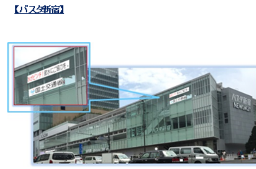
バスタ新宿(東京都新宿区) 写真2 2017(H29)年渇水での節水広報の状況
