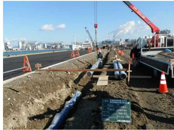
写真1-1 水道管の復旧工事（宮城県石巻市）
