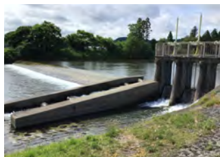
● 稲生川取水口
