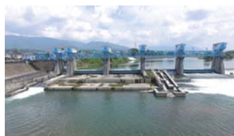
●小田頭首工(小田井土地改良区)
