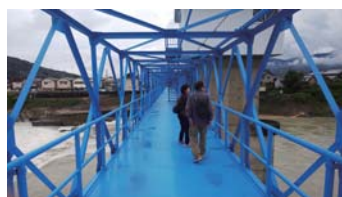
●管理橋内部見学
