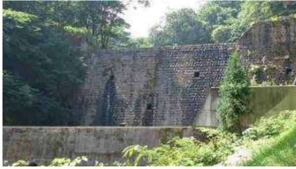
小水力発電の取水口にあたる東鴉川第3砂防堰堤は、昭和28年に完成し、完成から64年が経過しています。当時の砂防堰堤はこの川の石を加工し、積み上げて作られたもので文化庁の有形文化財として登録されています。当時の土木技術を後世へ残すために土木遺産としても登録されています。また、温泉街の人々を土石流等の自然災害から守るために、砂防堰堤が作られた歴史が感じられます。
