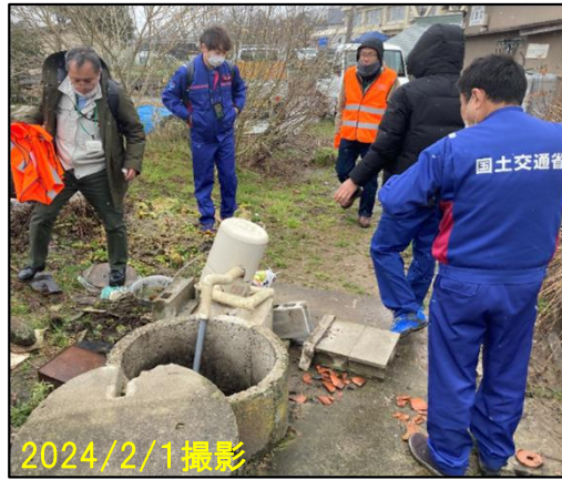
既設井戸現地調査状況
