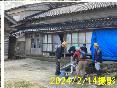
既設井戸現地調査状況
