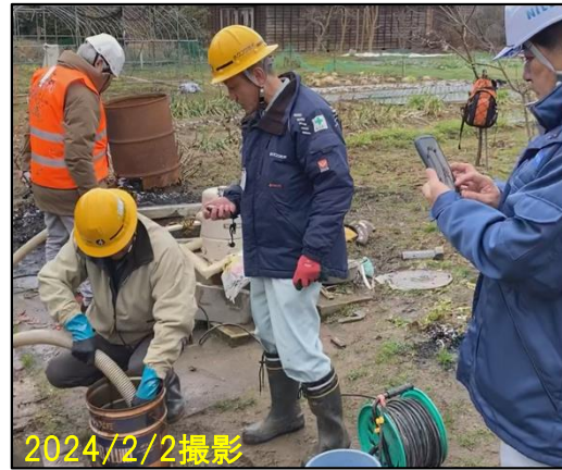
既設井戸における揚水試験状況
