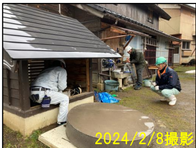
揚水試験実施状況
