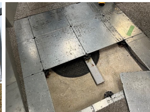
建物地下に設置された雨水貯留槽
