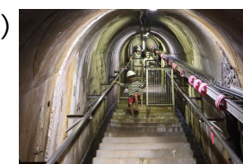
▲堤体内見学コース
