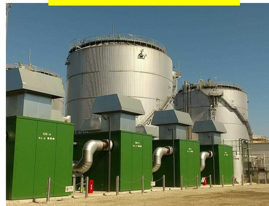
下水汚泥からバイオガスを発生・回収する
