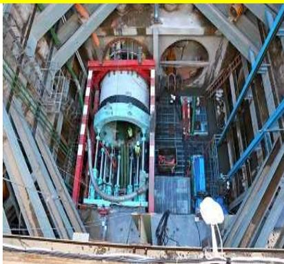
道路を掘り返さずに下水管を新設する
