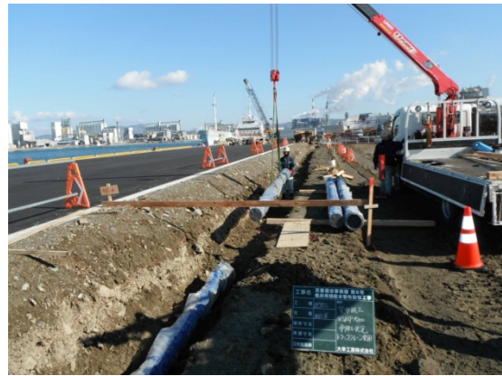
写真 9-1-1 水道管の復旧工事（宮城県石巻市）
