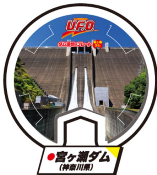
宮ヶ瀬ダム 関東地方整備局
