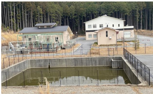
水源地域振興施設「田口浄化センター」
