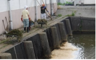
スクリーンの除塵作業
