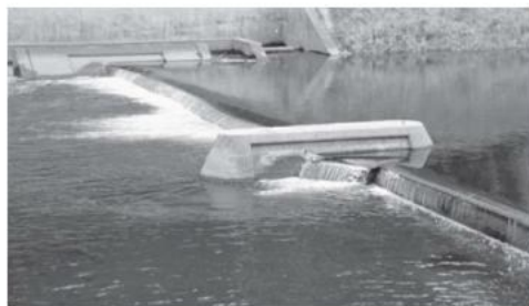
是川取水場でのラバーダムの運用訓練 新井田川の水量が減った際に、ラバーチューブを膨らませることにより、水位を確保し、浄水場へ水を送ります。
