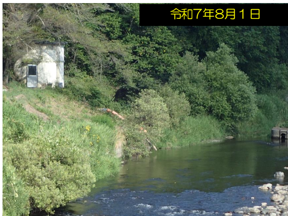
一戸町上水道取水口
