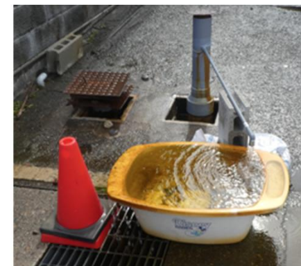
井戸前に貯水用に置かれたベビーバス（災害時地下水利用ガイドラインより）
