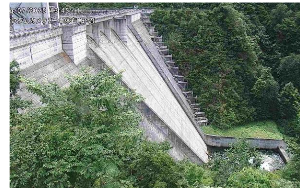
②岩堂沢ダムの放流状況(R7.8.7)
