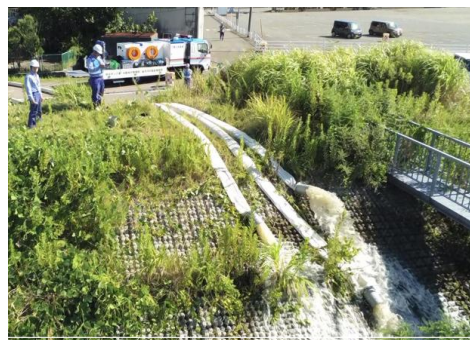
排水ポンプ車による排水支援[内水排除] (石川県金沢市)
