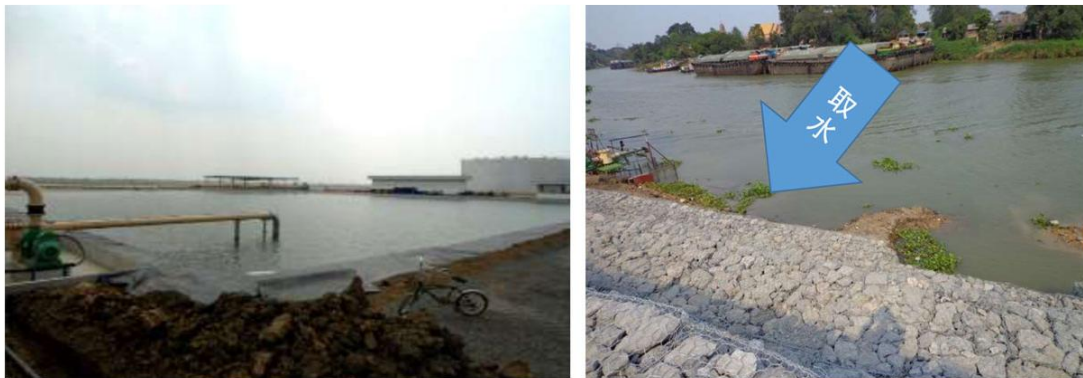
図3 渇水対策の取組事例（数週間にわたり操業可能な貯水池の設置、取水口位置を下げた様子）
