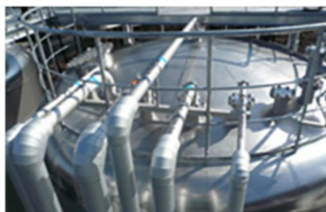
清浄レベルごとに回収した水を 200tのタンクに貯蔵し再利用
