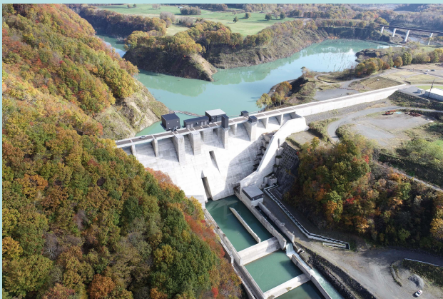
令和4年度に完成した平取ダム
