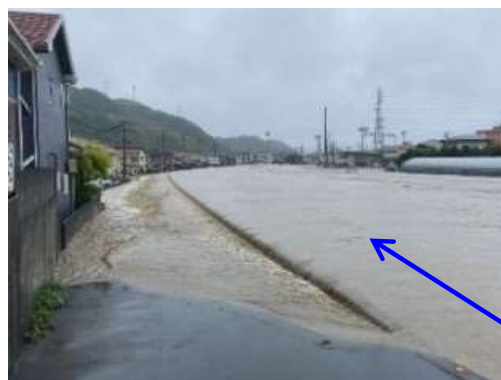
かめのがわ かめのがわ 亀の川水系亀の川の越水状況 わかやまし (和歌山県和歌山市)
