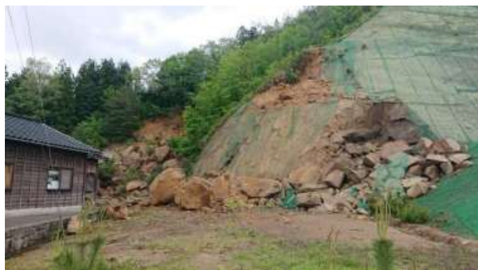
すずし しょういんまち がけ崩れによる被害(石川県珠洲市正院町)
