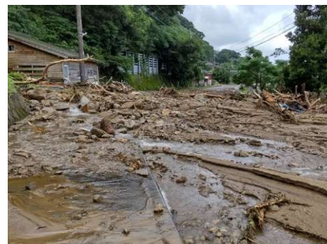
きもつきぐんみなみおおすみちよう 国道269号の土砂崩れ (鹿児島県肝属郡南大隅町)
