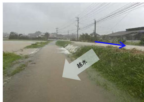
おおらがわ だいおうがわ 大浦川水系大王川の越水状況 みなみ (鹿児島県南さつま市)
