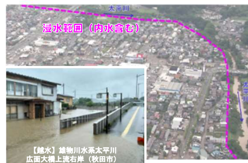
浸水被害の発生状況 あきたし (秋田県秋田市)
