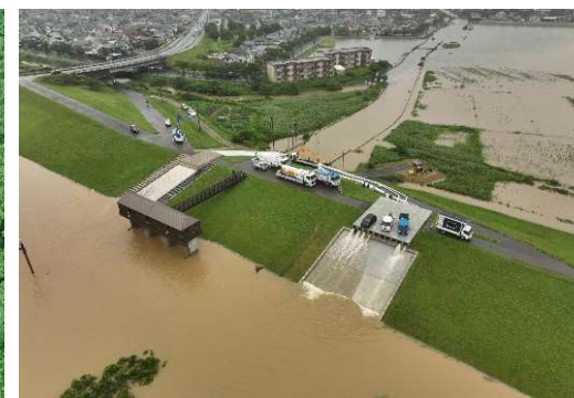
排水ポンプ車による排水活動 あきたし (秋田県秋田市)
