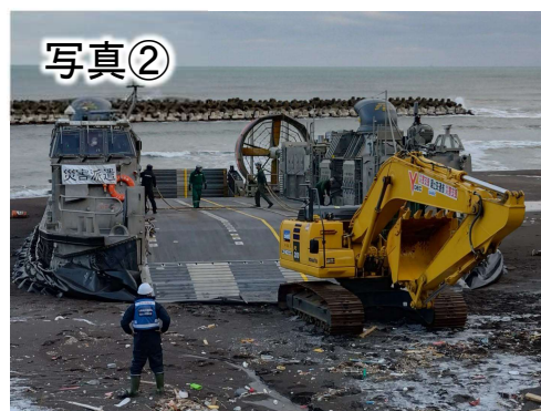
写真② 深見海岸 海側からの 重機運搬(1月14日撮影)
