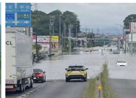
とよかわし 国道1号の冠水状況(愛知県豊川市)
