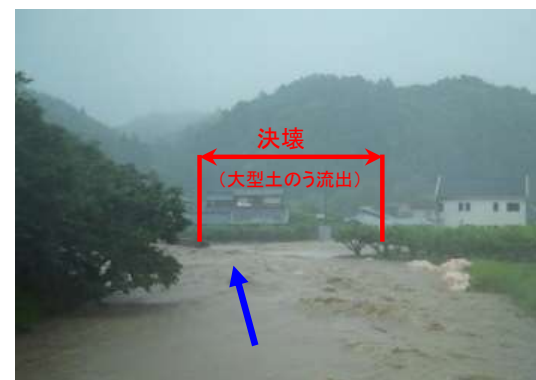
おおたがわ しきじがわ いわたし 太田川水系敷地川の決壊(大型土のう流出)(静岡県磐田市)
