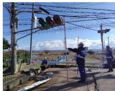
道路の被災状況調査 (石川県内灘町)
