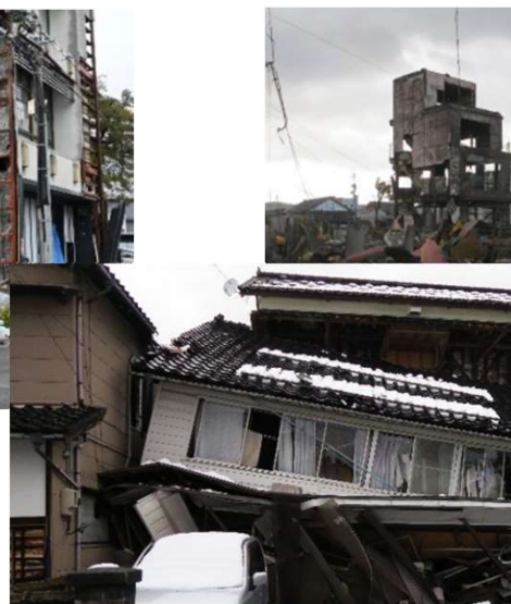
木造建築物の倒壊状況(穴水町)
