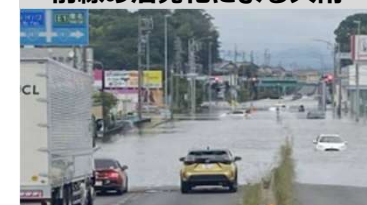
国道1号の冠水状況（愛知県豊川市）
