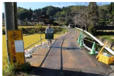
道路の損傷について査定を待たずに応急工事を実施し、早期に仮設道路を設置
