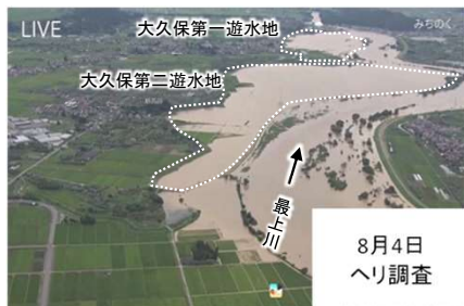
【遊水地への湛水状況(令和4年8月4日)】
