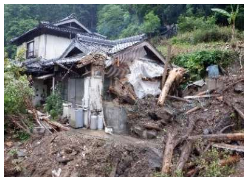
ありだぐん ありだがわちよう 土石流による被害(和歌山県有田郡有田川町)
