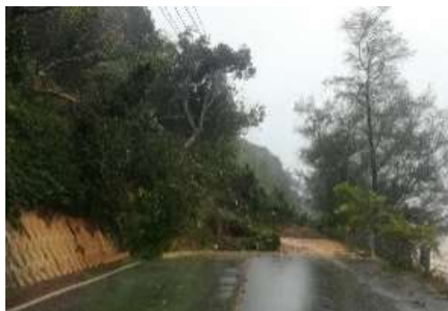
なごし 国道505号の土砂崩れ(沖縄県名護市)
