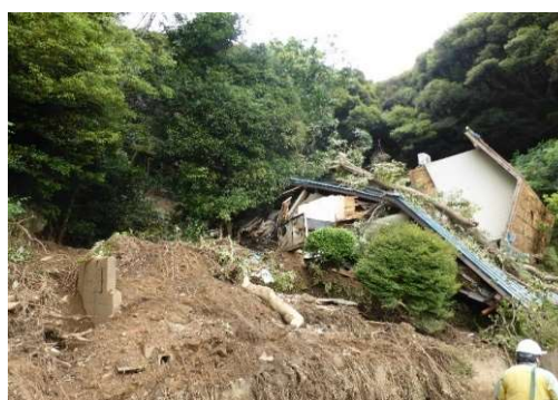
とよかわし 土石流による被害(愛知県豊川市)
