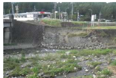
河岸の欠壊について、拡大防止のために大型土のうで対策を実施
