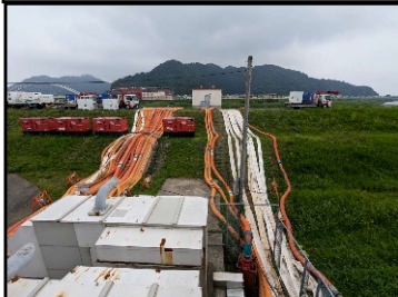
写真③ 排水設備状況
