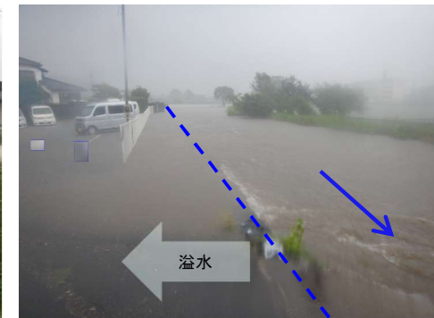
こくぶがわ ふないれがわ なんこくし 国分川水系舟入川の溢水状況(高知県南国市)
