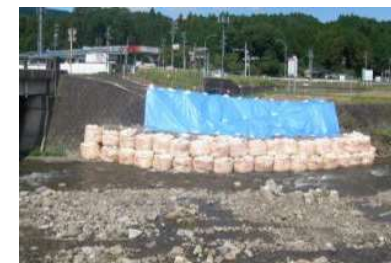
河岸の欠壊について、拡大防止のために大型土のうで対策を実施
