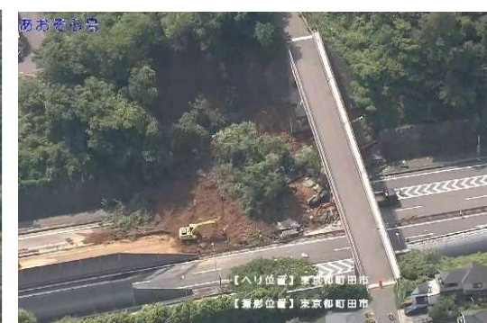
まちだし 国道16号の法面崩壊状況(東京都町田市)
