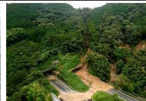
E34大分道の土砂流入 あさくらし (福岡県朝倉市)
