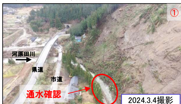
下流部 河道埋塞箇所
