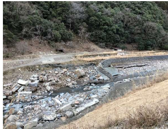
河川施設(護岸)の被災
