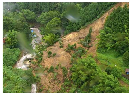
地すべりによる被害(大分県由布市) ゆふし
