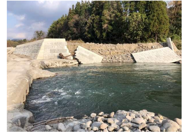
河川施設(護岸)の被災
