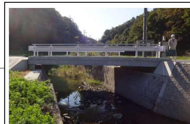
復旧橋梁全景写真
