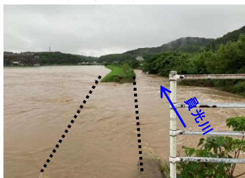
かんだがわ かずみつがわ しものせきし 神田川水系員光川の決壊(山口県下関市)
