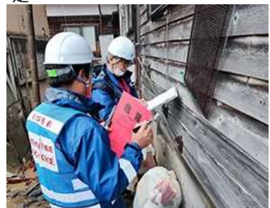
被災建築物応急危険度判定 (石川県六水市)
