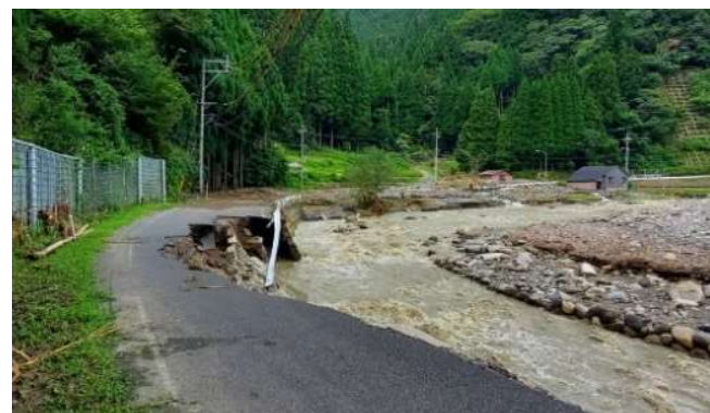
とっとりし 国道482号の土砂流出(鳥取県鳥取市)
