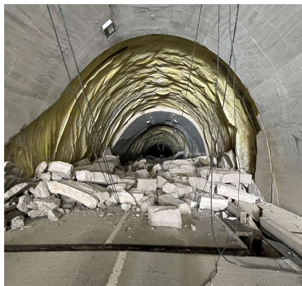
国道249号大谷トンネル(珠洲市)
