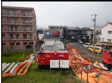
写真② 排水設備状況
