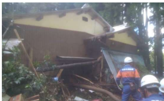
いちはらし がけ崩れによる被害(千葉県市原市)
