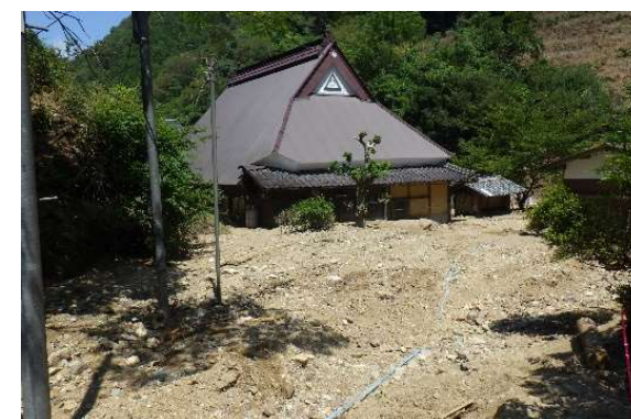
まいづるし 土石流による被害(京都府舞鶴市)
