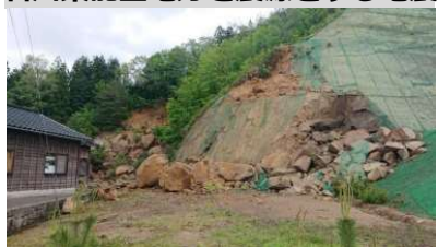
すずし しゅういんまち がけ崩れによる被害（石川県珠洲市正院町）
