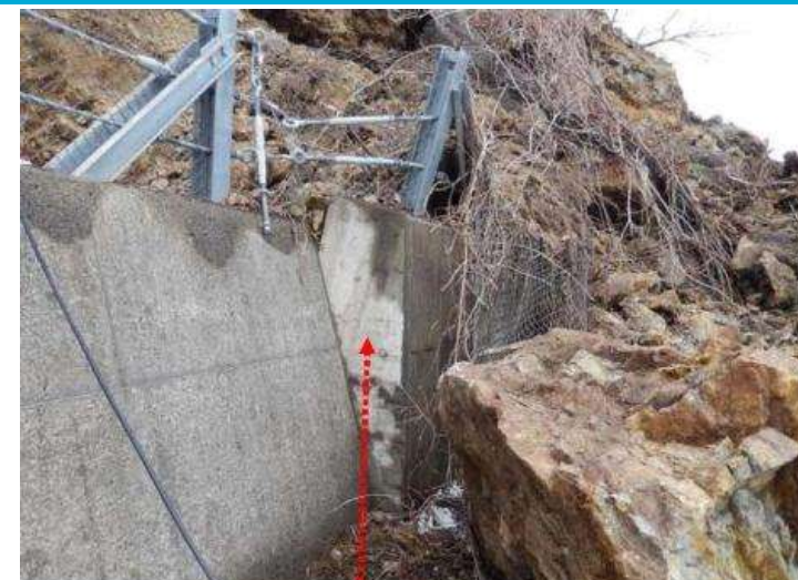
終点側のスパン、天端幅分は移動している。 基礎地盤は破壊していると思われる
