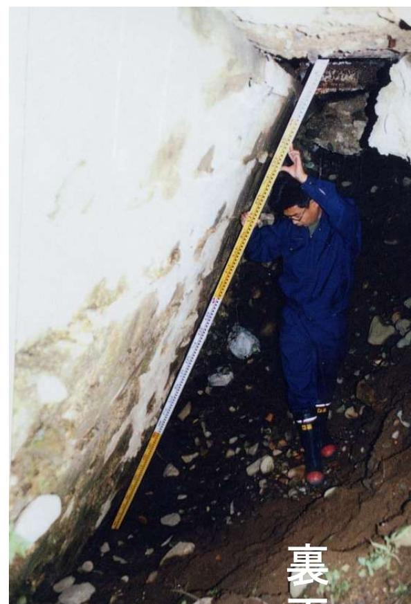
護岸を生かしながら、根継工や背面土砂の充填は無理⇒**死に体**
