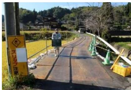
道路の損傷について査定を待たずに応急工事を実施し、早期に仮設道路を設置
