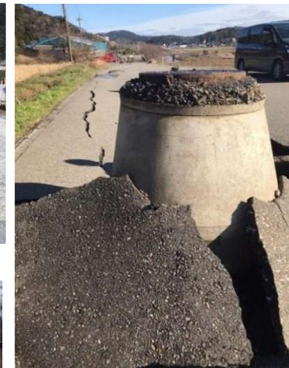
下水道マンホールの浮き上がり(輪島市)
