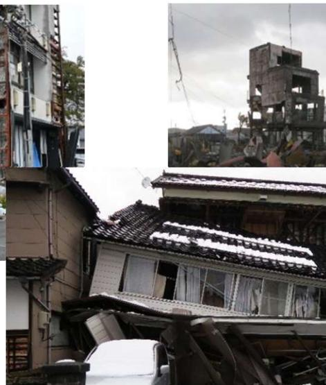
木造建築物の倒壊状況(穴水町)
