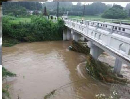
橋梁基礎部の洗掘、橋脚に流木が引っかかり橋台の
