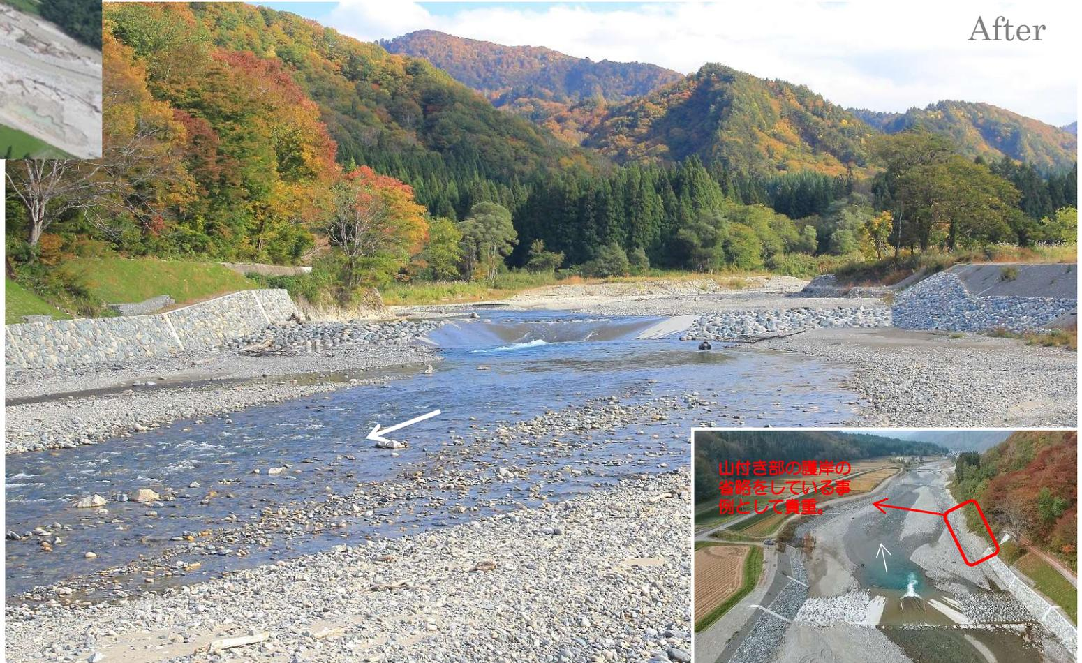
そのほか、流速が低減する**河道拡幅部の右岸側山付き部分**は、**護岸を整備しない**。落差工は、スロープ形式として魚類の移動阻害を緩和する等、自然の機能を残すような工夫が行われています。
