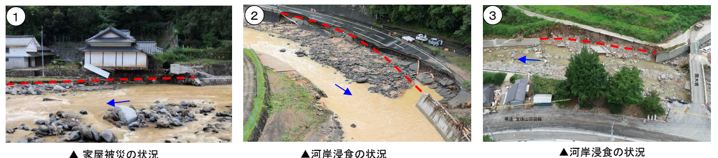
▲ 家屋被災の状況
