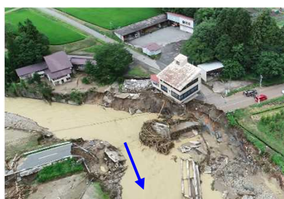
▲大巻橋落橋、家屋の被災状況
