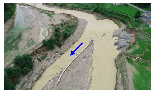
▲河岸侵食状況
