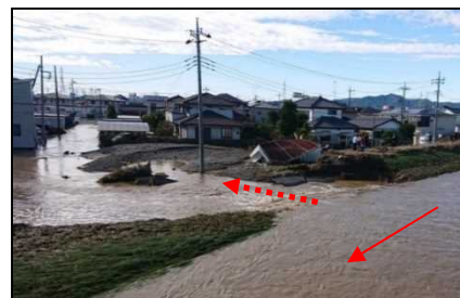
▲①秋山川(海陸橋上流右岸)決壊箇所状況
