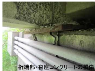
伸縮装置部の損傷（左岸側 A1橋台）
