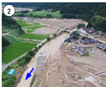
▲河岸侵食の状況
