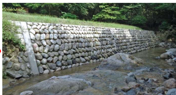
被災施設を原形で復旧
