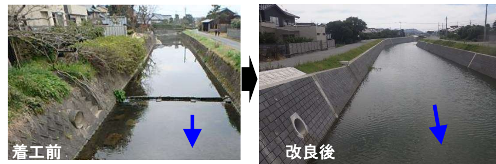
着工前 改良後 みょうけんがわ H29年災 筑後川水系妙見川助成（福岡県） ※護岸工の復旧＋河道拡幅
