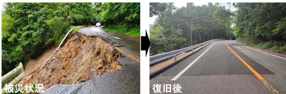
被災状況 復旧後 ひこさんかわらせん R3年災 県道 英彦山香春線（福岡県） ※道路の復旧
