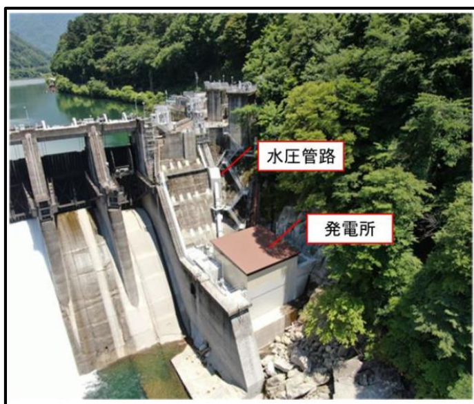
南木曾吾妻発電所 設備外観写真
