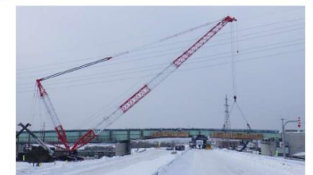
令和3年1月北24条大橋架設（札幌市）
