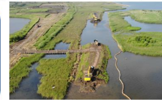
令和2年7月矢臼場河道掘削（石狩川）
