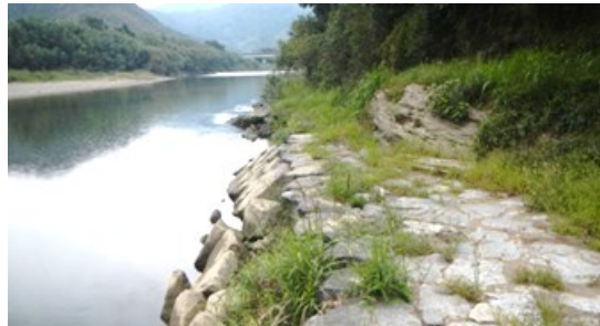
地上写真(護岸・水制の状況)
