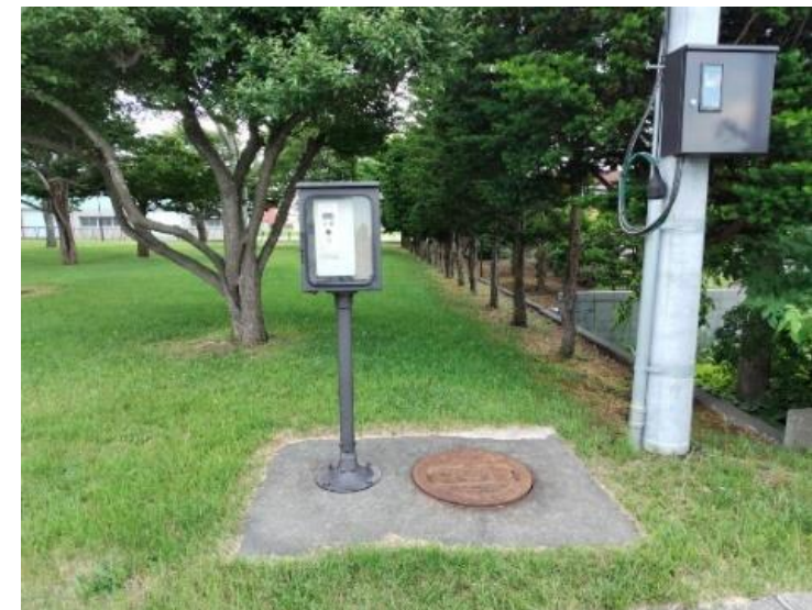
非常用地下水（本社敷地内）
