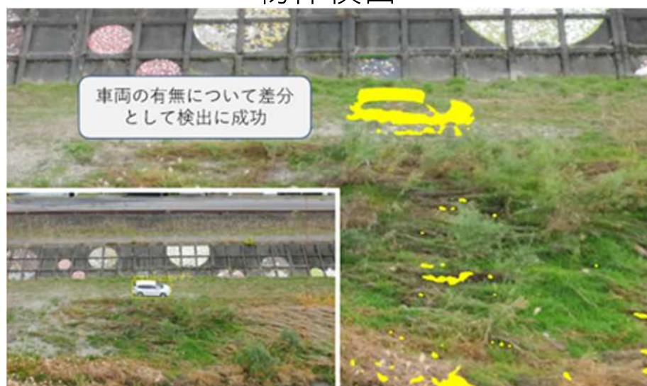
差分による異常検出
