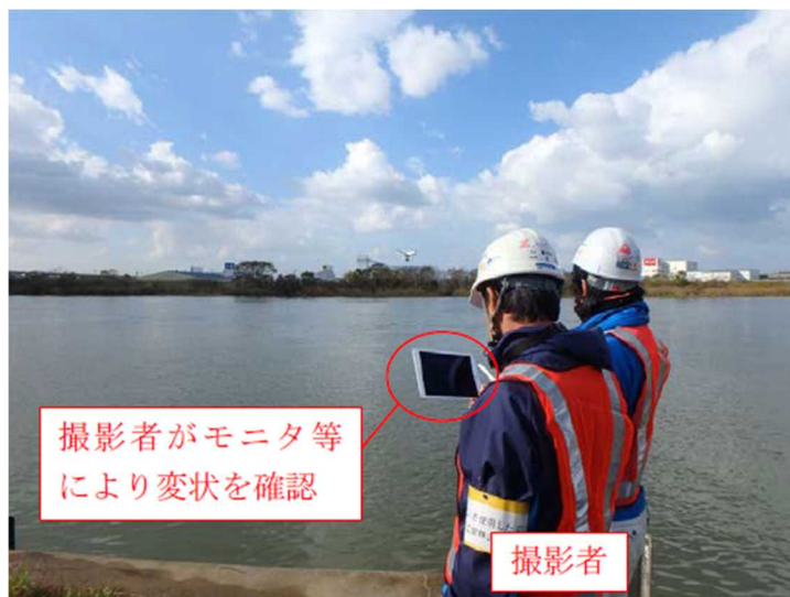
図 5-2 現地における変状の確認方法
