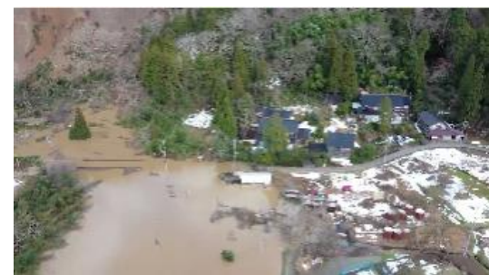
能登半島地震 (R6.1.1) (石川県輪島市)TEC-FORCE撮影
