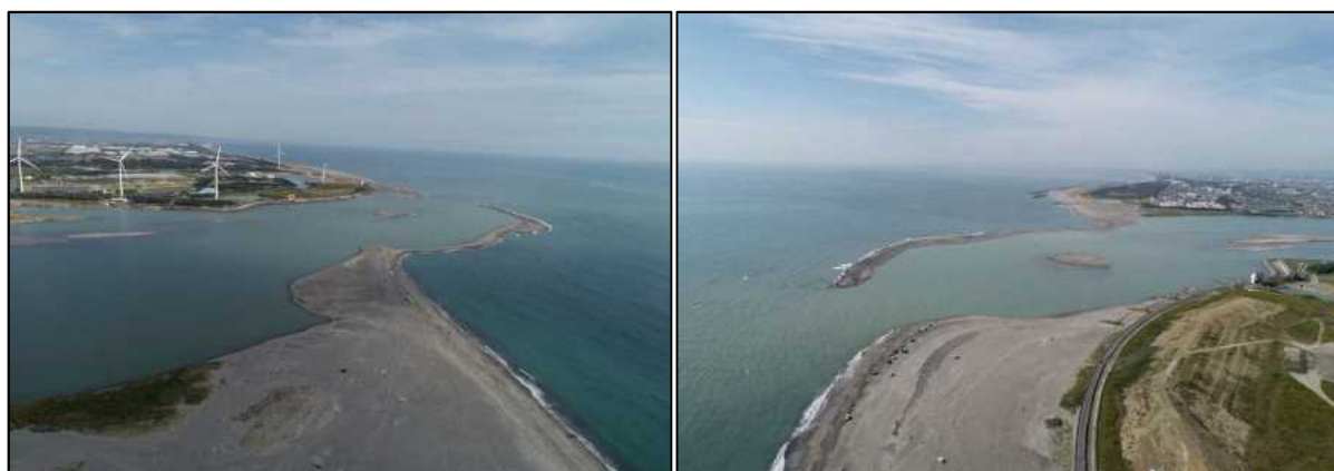
図 5-9 ドローンから撮影した河口砂洲の状況
