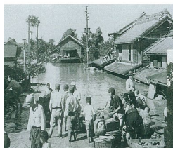
栗橋町の浸水状況
