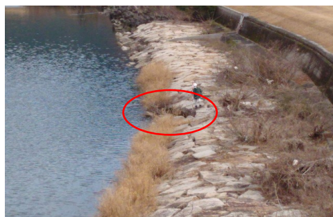
図 2-7 ドローンによる基礎部の洗掘の確認例 (上: ドローン取得データ、下: 地上からの確認結果)
