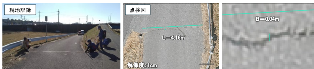
図 2-22 亀裂の評価例
