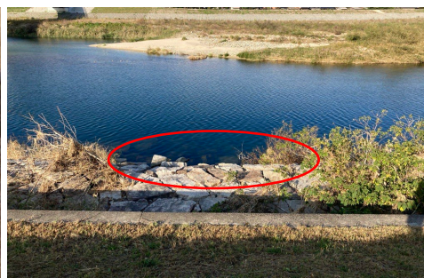
図 2-7 ドローンによる基礎部の洗掘の確認例 (上: ドローン取得データ、下: 地上からの確認結果)
