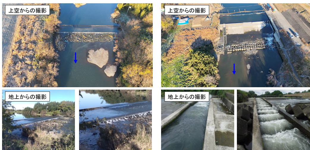
図 2-2 堰・床止め等の横断工作物の状況把握例
