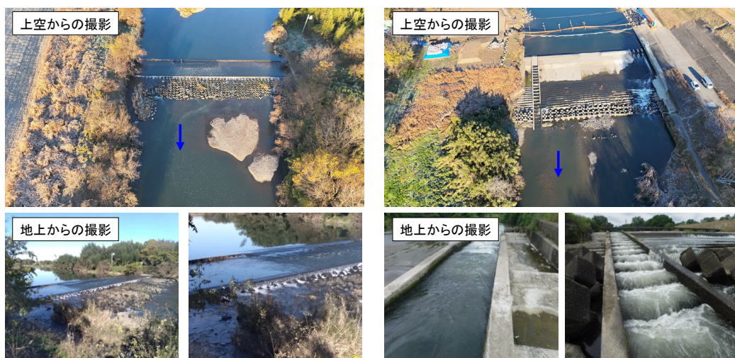
図 1-2 河川巡視において得られた情報例（堰・床止め等の横断工作物の状況把握）
