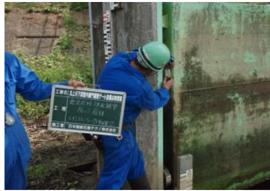
構造物点検による 水門ゲートの状態把握
