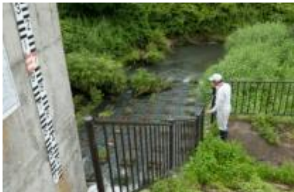
巡視項目、目的、場所等を絞り込んで行う巡視
