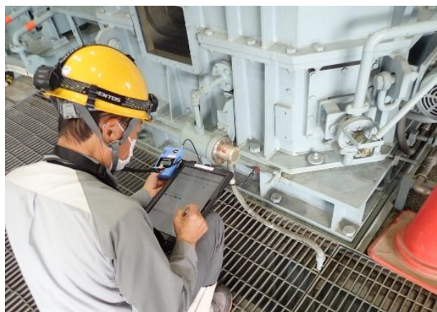
タブレットを利用した点検記録
