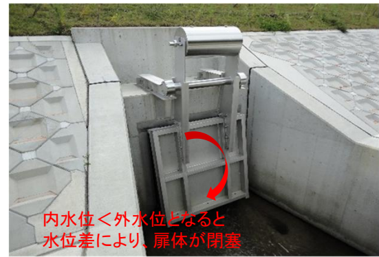
外水位側の水圧により、扉体が閉塞
