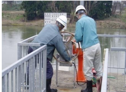
(樋管の機側操作)
