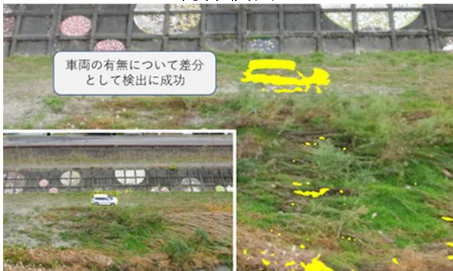
差分による異常検出
