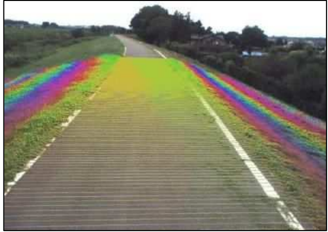
堤防の3次元点群データ
