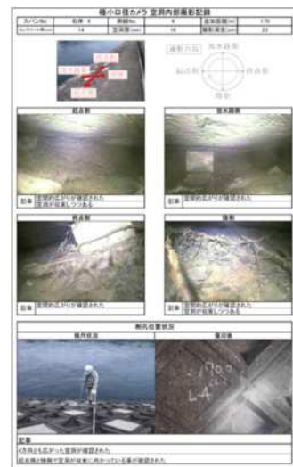
空洞内部撮影
