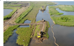
令和2年7月矢白場河道掘削（石狩川）
