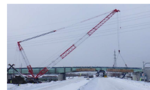
令和3年1月北24条大橋架設（札幌市）
