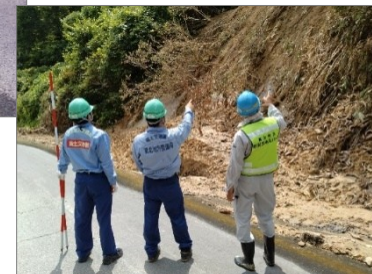
TEC-FORCEとの 被災状況調査の様子 （山形）
