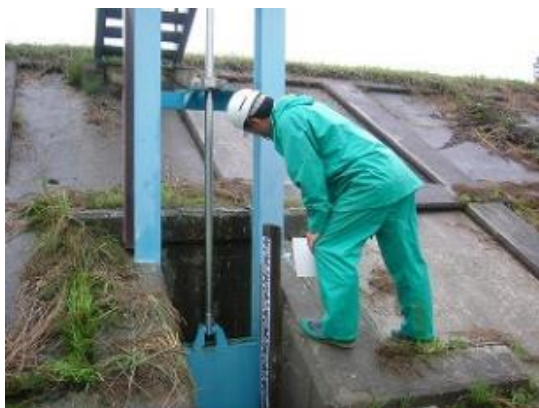
ゲート施設の点検開閉状況の確認
