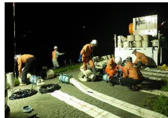
夜間で現地対応 (緊急排水対応)
