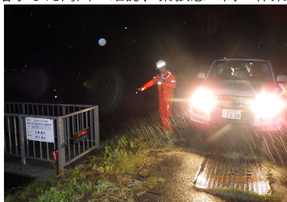
夜間増水時における 管理施設の異常有無の確認
