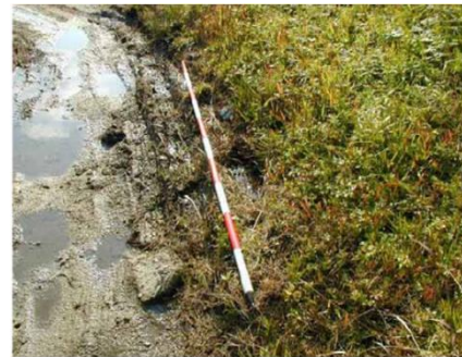
漏水箇所の確認
