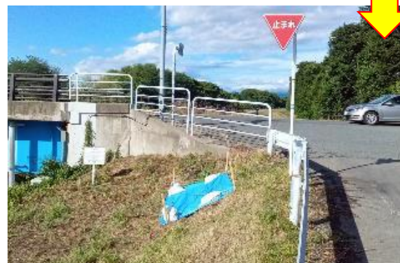
応急補修 (法面小規模陥没)
