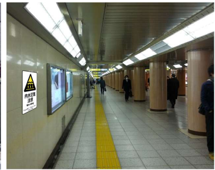
地下施設への添架型標示
