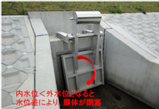
外水位側の水圧により、扉体が閉塞
