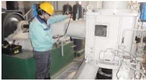
定期点検の実施
